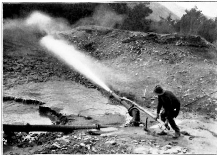
Aus einer Art Wasserkanone wird ein Wasserstrahl gegen den Berghang geschossen. (G. 27.)
